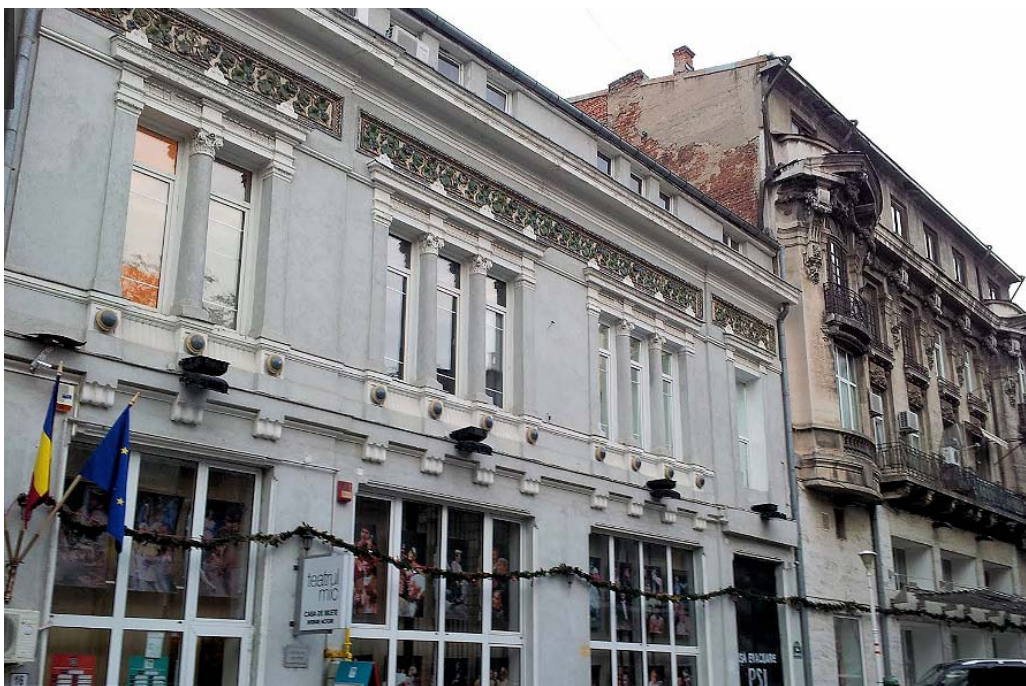
Fig. 2 – Teatrul Mic înainte de renovare (în dreapta, imobilul principal, cu sala de spectacole și foaietul).
